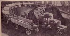
Рис. 470. Дорожный поезд Аустро-Даймлер типа «Ландвер» с бензино-электрическим приводом и прицепами, двигающимися по следу тягача (1912 г.).
