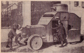
Рис. 402. Легкий броневедомитель Бианчи. Видны расширенные обода передних колес для передвижения по пескам.
