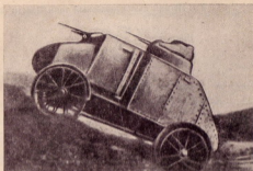
Рис. 410. Тяжелый высококопесный танк Павези Л-140. Увеличение размеров боевого отделения машины (в обеих частях корпуса) вошло на счет менее выгодного, чем у легких танков, взаимного расположения колес.
