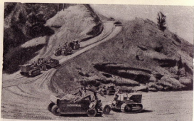
Рис. 680. Механизация итальянских дорожных работ в Абиссинии. Оставшийся после прохода грейдеров грунт подбирается специальными прицепками, буксируемыми тракторами.
