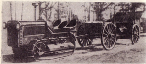
Рис. 645. Трактор Катерпиллер в момент буксировки полевой пушки на огневую позицию.
