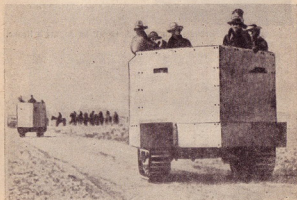
Рис. 467. Мексиканские «суррогатные» танки, переделанные из сельскохозяйственных гусеничных тракторов.
